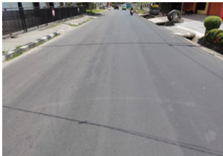
Gambar 11. Hasil Akhir Pekerjaan Latasir Kelas B (SS-B)
