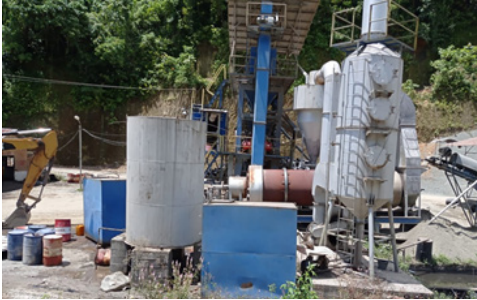
Gambar 5. Unit Peralatan Pencampur (AMP) di Desa Laha-Ambon
