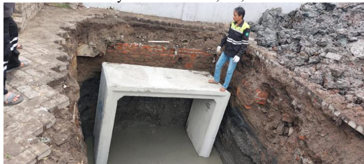
Gambar 18. Pemasangan U-Gutter untuk mengurangi getaran yang terjadi
